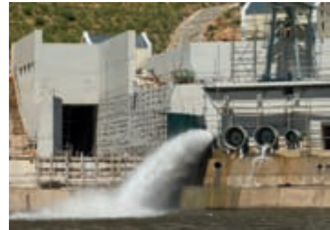
BERG RIVER DAM
